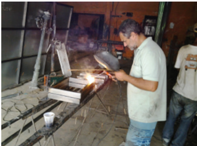
Produção da estrutura metálica
