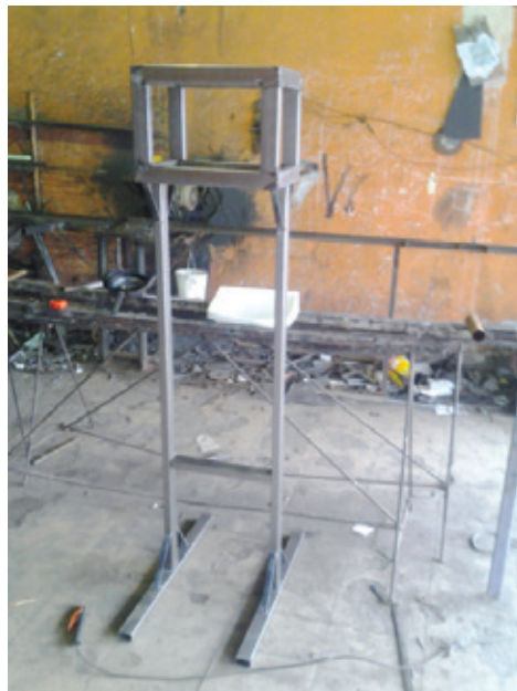
Estrutura metálica concluída
